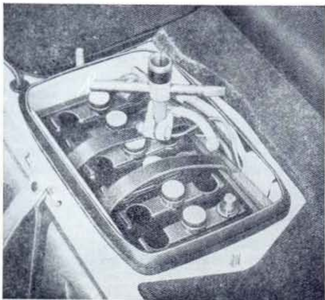
Sl. 341. — Čišćenje kleme priključaka akumulatora pomoću alata A. 76002.
